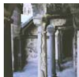
Éclatement de la pierre - Piliers de la cathédrale. Source: Œuvre Notre-Dame
