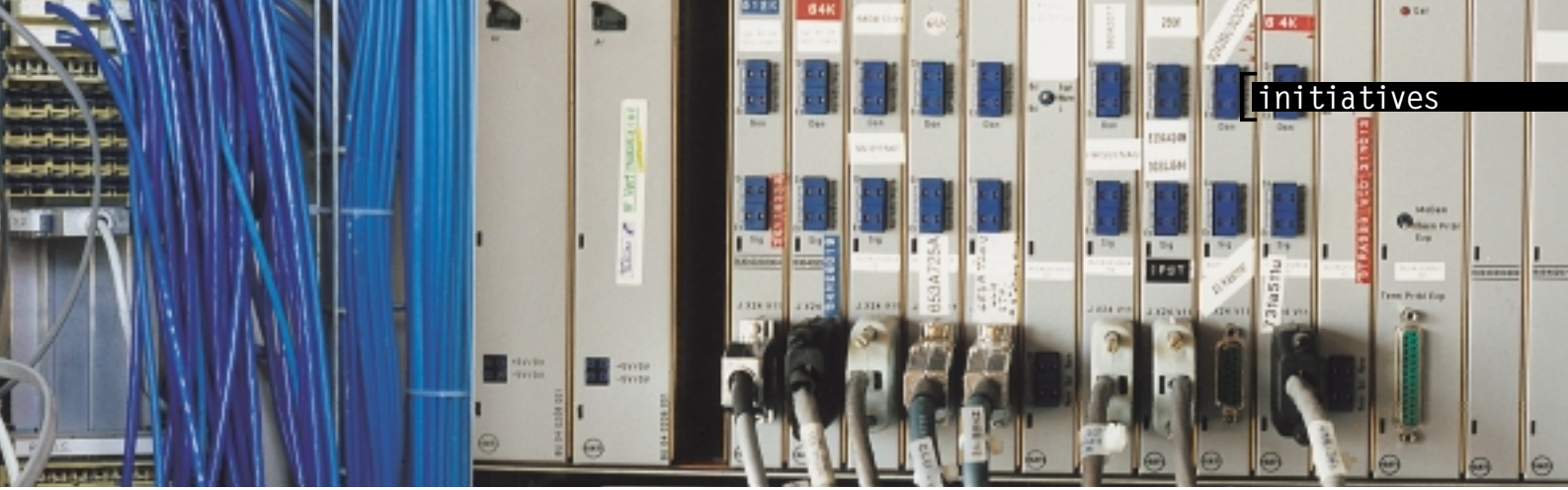
Phases de câblage pour la mise en place d'Osiris
