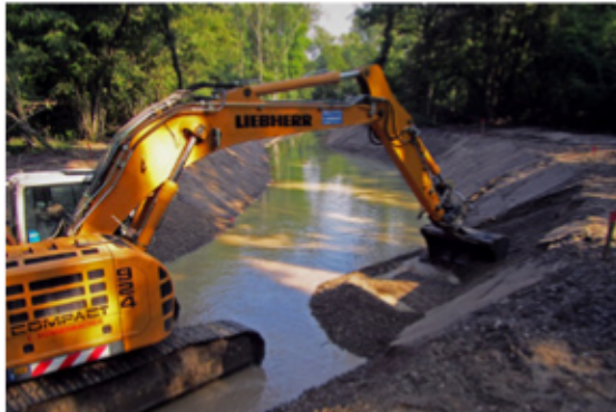
Creusement du chenal de reconnexion.
